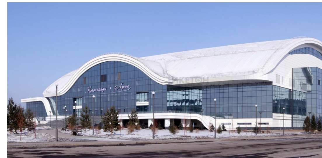
Строительство Ледового Дворца в г. Караганда
