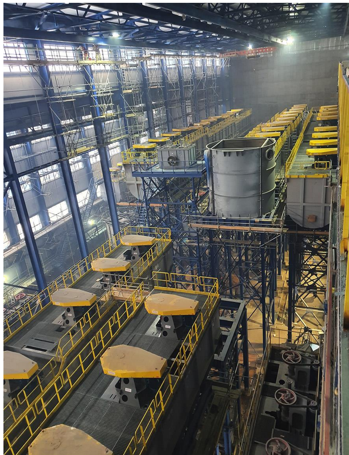
ЖГОК . Промплощадка. РВС 10000 м3, РВС 5000 м3
